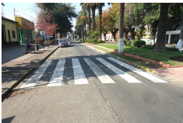
Conservación de vías urbanas.
